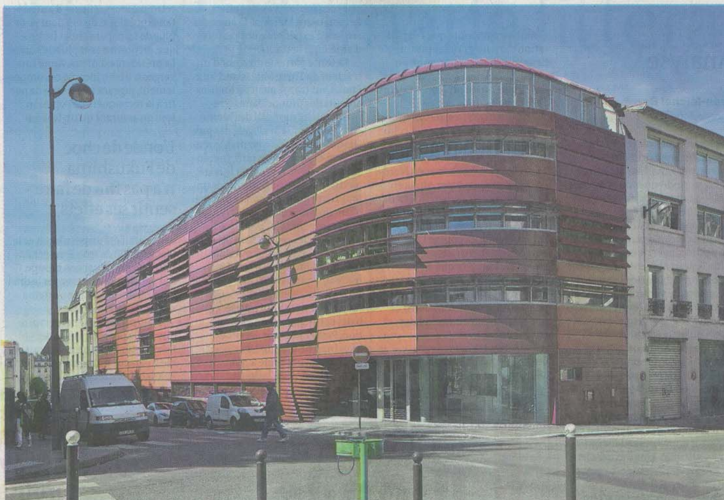
Un bâtiment de 62 logements étudiants conçu par Brigitte Metra et inauguré cette année, dans le 11 e arrondissement de Paris. PHILIPPE RUAULT
