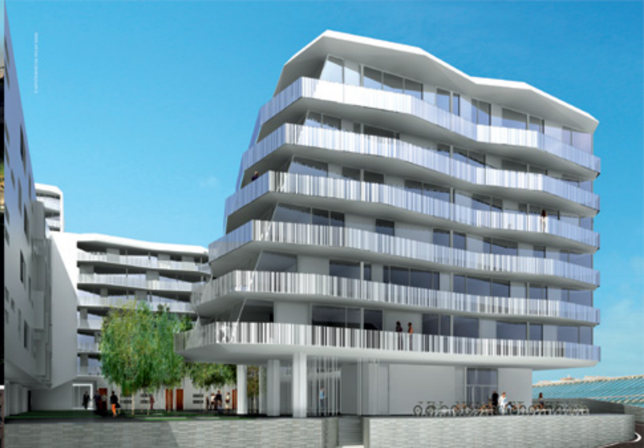
Remise de bus et logements sociaux, Paris 14 e – Atelier Seraji.
